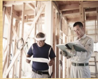
1月 優秀賞 (会津若松建設事務所長賞) (株)成田木材建設
