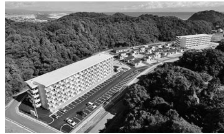
当社施工の「災害公営住宅薄磯団地新築工事」
