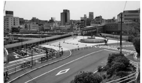
当社施工の「いわき駅北口広場整備工事」
